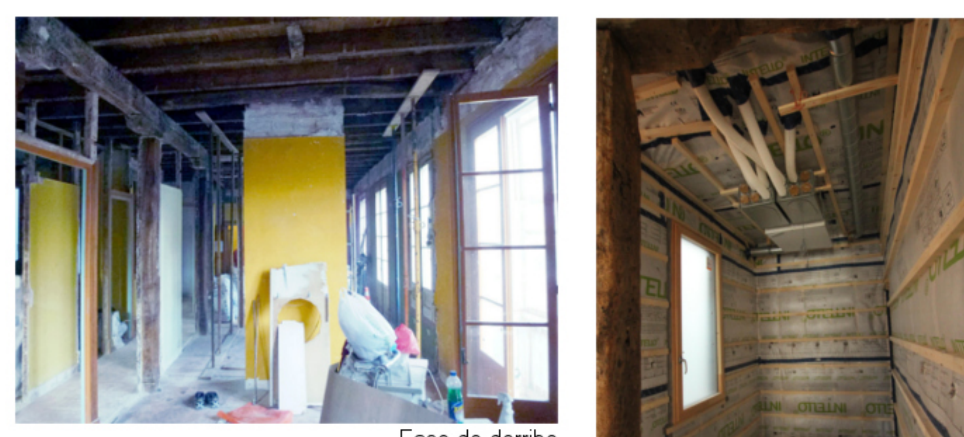
Fase de derribo
