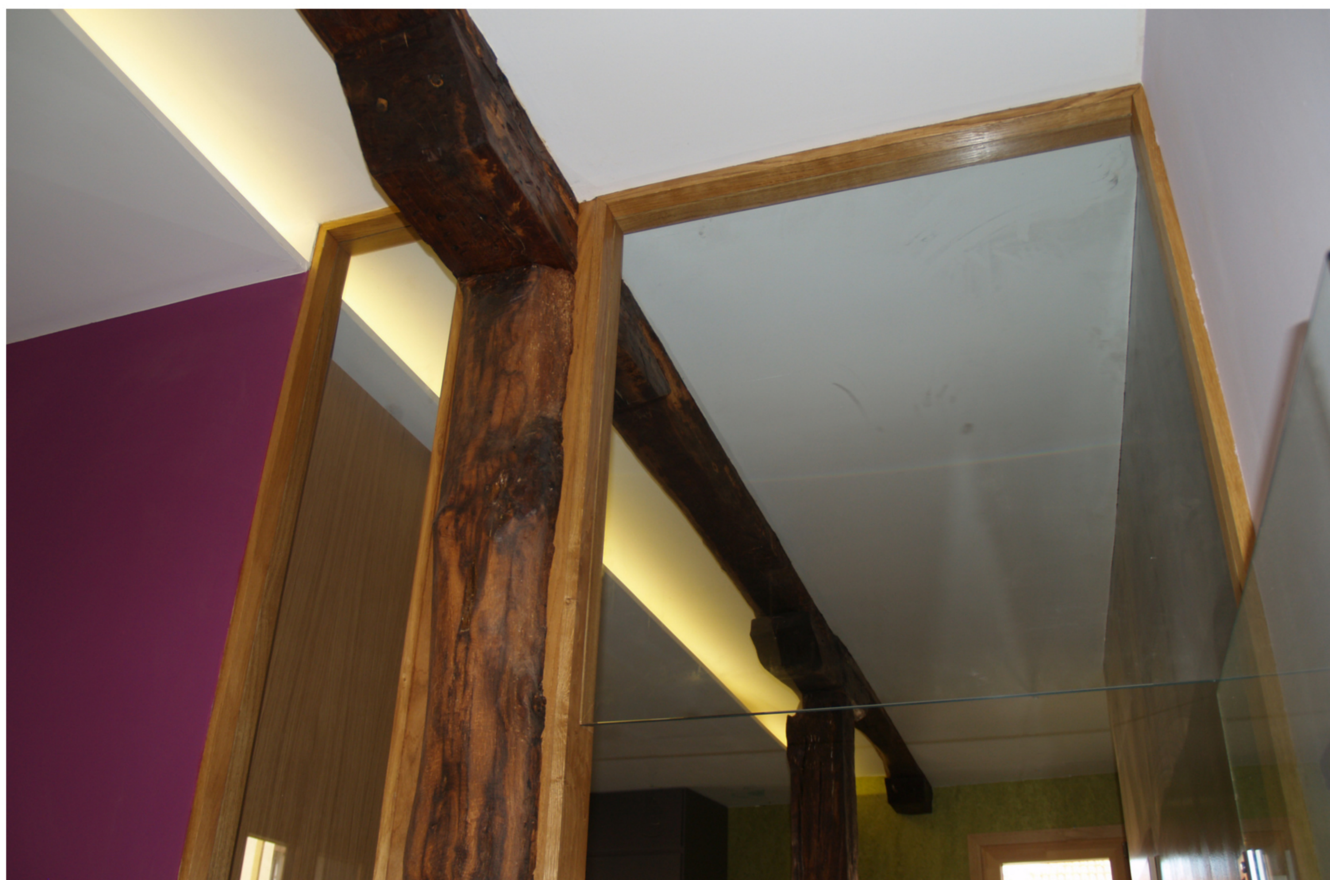
Estructura principal de madera
